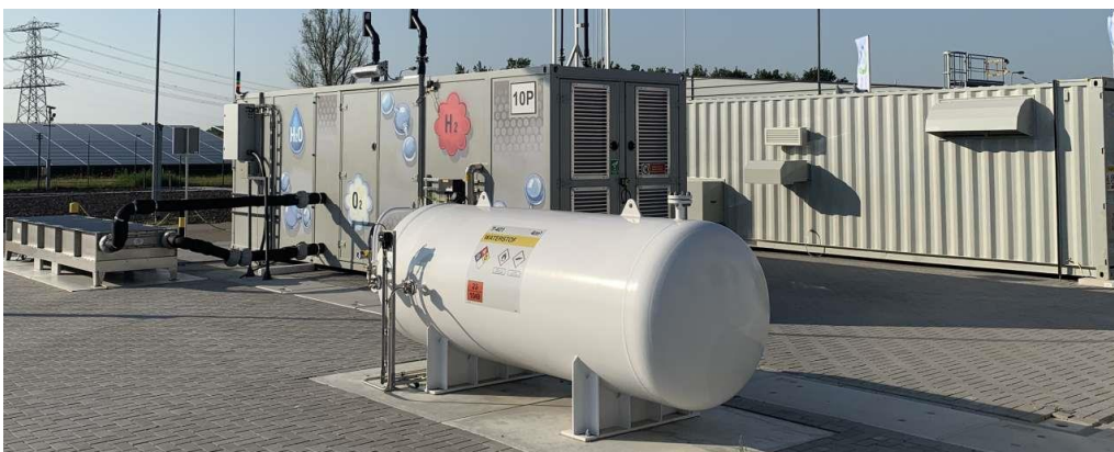
Figuur 4.2 1 MW PEM-electrolyser-plant bij HyStock-project (Zuidwending, NI) 16
