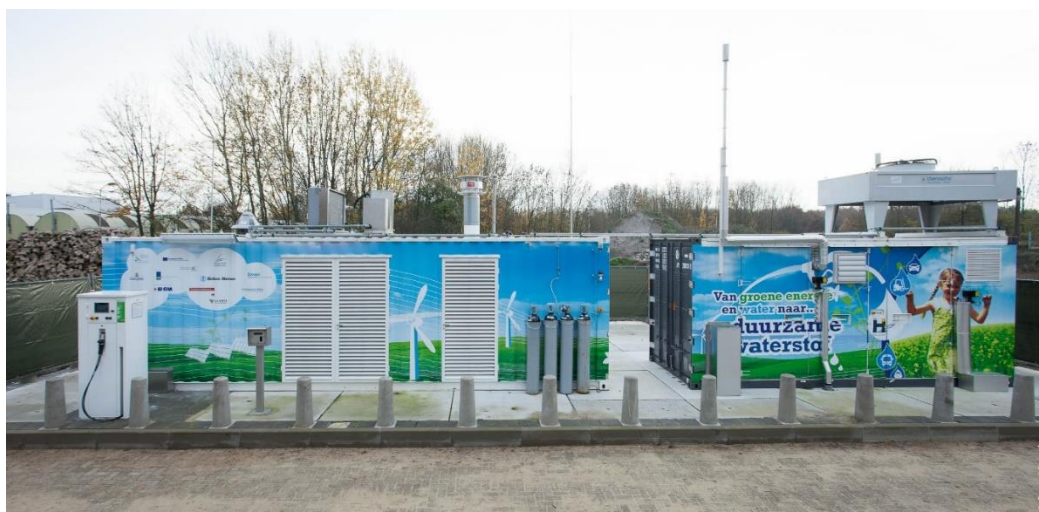
Figuur 4.4: 0,6 MW alkalische elektrolyse bij WaterstofNet HRS (Helmond, NI) voor de levering van waterstof aan auto's, bussen, vuilniswagens en vrachtwagens
